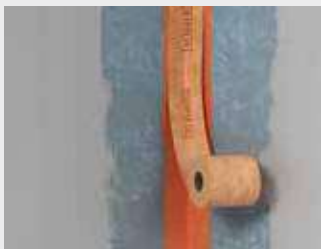
35 pav. Įspauskite fermacell sandarinimo juostą ant dar drėgnos fermacell hidroizoliacinės dangos ir padenkite skysta hidroizoliacine danga
