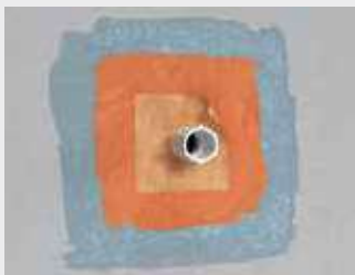
36 pav. Norėdami užsandarinti vietas, kuriose išsikišę vamzdžiai, uždėkite vamzdžiams skirtas sandarinimo priemones ant dar drėgnos fermacell hidroizoliacinės dangos ir padenkite skysta hidroizoliacine danga
