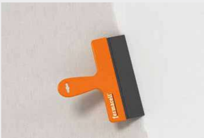
44 pav. fermacell gipso plaušų plokščių paviršiaus glaistymas
