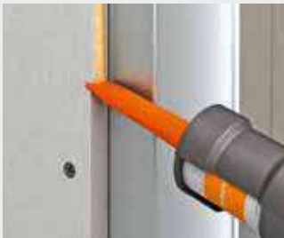
47 pav. Klijuota siūlė
