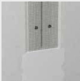
46 pav. Plokščių nuožulniomis briaunomis siūlė
