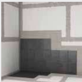
31 pav. Plytelių klijavimas
