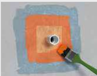
36 pav. Norėdami užsandarinti vietas, kuriose išsikišę vamzdžiai, uždėkite vamzdžiams skirtas sandarinimo priemones ant dar drėgnos fermacell hidroizoliacinės dangos ir padenkite skysta hidroizoliacine danga
