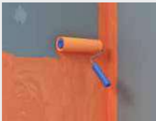
37 pav. 2x pilnas paviršiaus padengimas fermacell hidroizoliacijos danga Waterproofing Application , naudojant volelį (minimalus bendras storis 0,5 mm).
