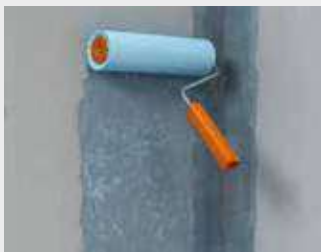
34 pav. Pilnas paviršiaus padengimas fermacell gruntu Deep Primer
