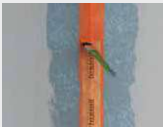
35 pav. Įspauskite fermacell sandarinimo juostą ant dar drėgnos fermacell hidroizoliacinės dangos ir padenkite skysta hidroizoliacine danga
