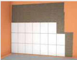
38 pav. Plytelių klojimas, naudojant fermacell plytelių klijus Flexible Tile Adhesive , priklausomai nuo drėgmės poveikio klasės.
